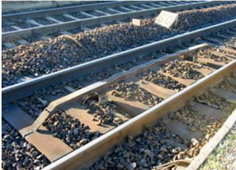
**Figure 15 Aspect d'un crocodile sur ligne classique**
